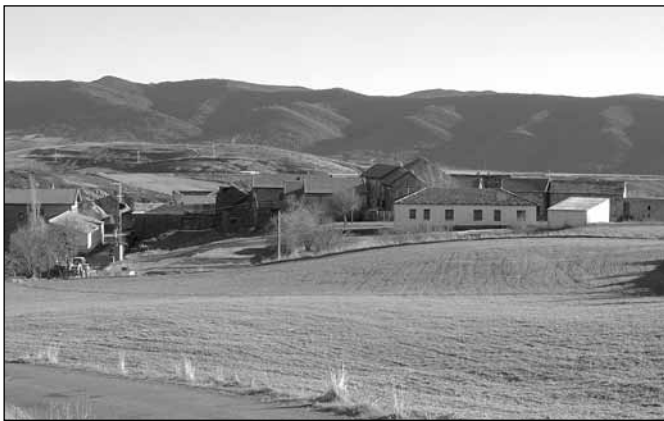
Novés: depósito de agua, herrería, accesos...
