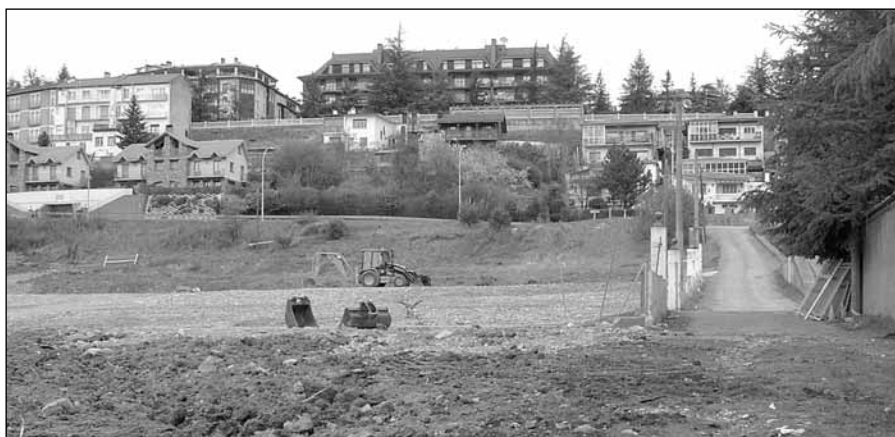
Han comenzado las obras de acondicionamiento del terreno donde se ubicará la nueva pista
