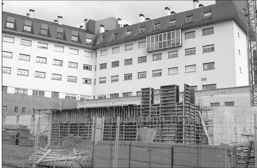
Obras de ampliación y mejora del hospital de Jaca
