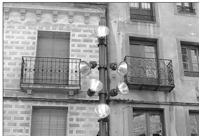
Detalle de la nueva iluminación de la plaza de la Catedral
